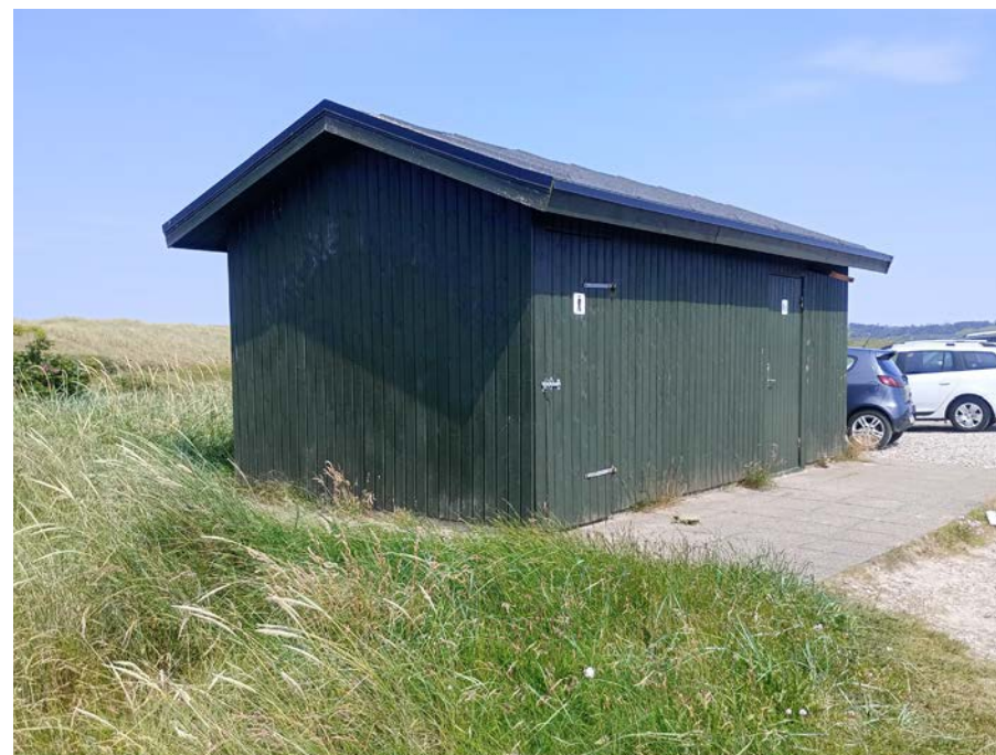
Eksisterende toiletbygning og uformel parkering
