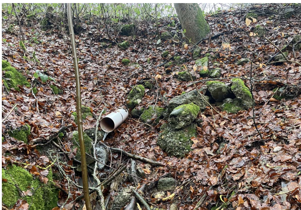
Figur 40. 200 mm rørudløbet under Øghave Stien med styrt ned i Lille Slugt.
