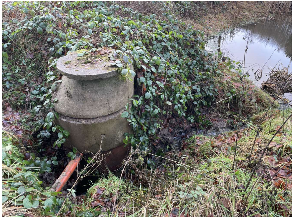
Figur 17. Den eroderede brønd i afløbet fra søen ved Hesbjerg Skovvej sydøst for Malurtebjerg set i december 2022.
