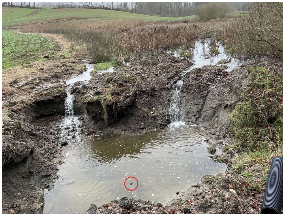
Figur 12. Styrtet i udløbet af søen nordvest for Hesbjerg Skov med afløb til et lodret stille rør vist i den røde cirkel i billedet. Set i december 2023.
