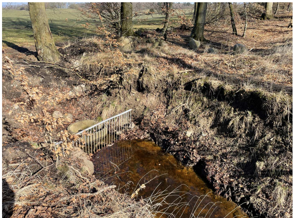
Figur 9. Hovedgrøften fra Lerbjerg Skov løber ind i en brønd bag gitterristen og videre ind i en 30 cm rørledning under marken mod nordvest i marts 2022.
