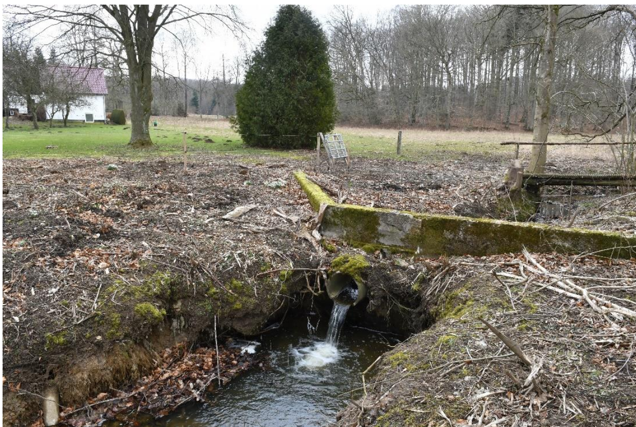
Figur 5-6. Spærring i vandløbet i afdeling 28 (29)
