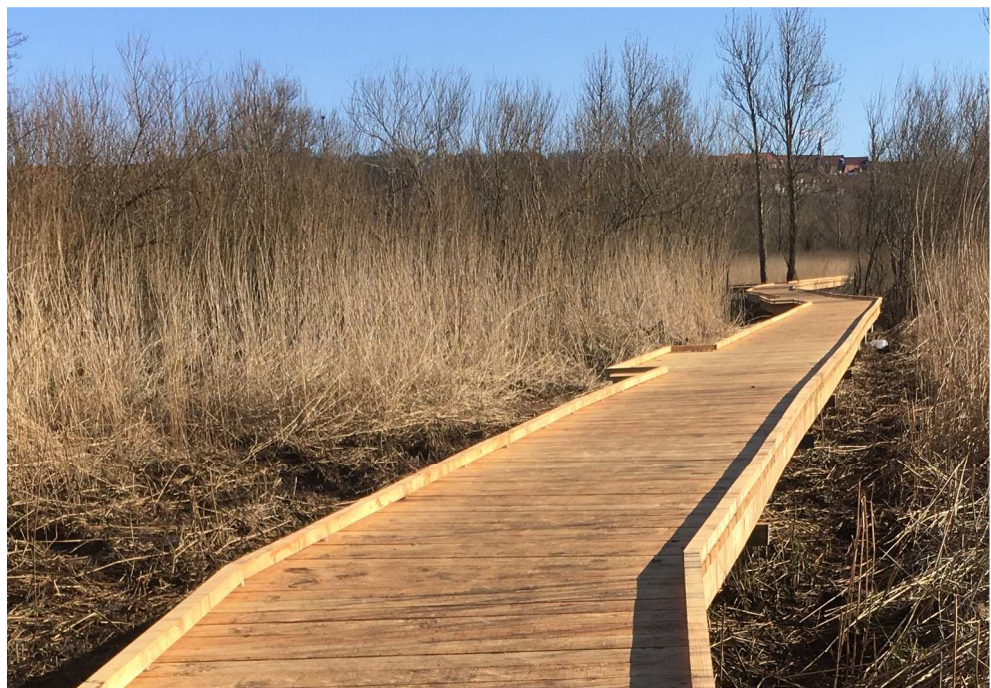
Figur 22. Eksempel på en avanceret 1,5 m bred handicapvenlig boardwalk af lærketræ funderet og hævet over terræn på 4 skruerpæle per 3,0 m igennem et dybt blødbundsområde i Gudenåparken i Randers. Boardwalken er forsynet med en 50 mm hævet fodliste i hver side for at beskytte mod udskridning.
